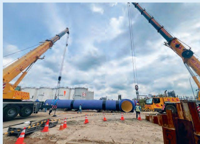
工地现场正在进行水管道的铺设工作。
