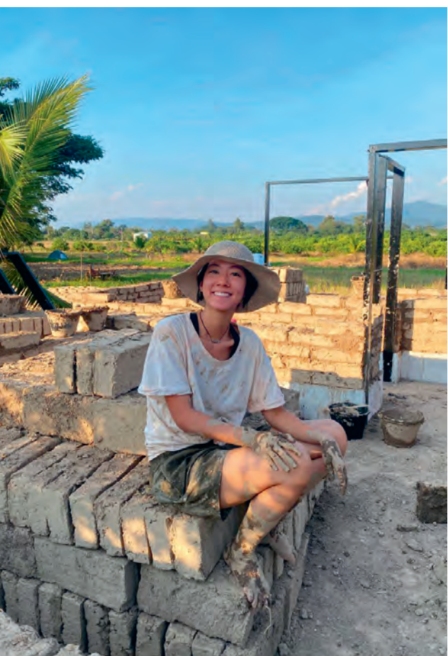
智俐去年到清迈参加一个土坯建筑课程，用黏土、稻壳和稻草，搭建一座房子。
