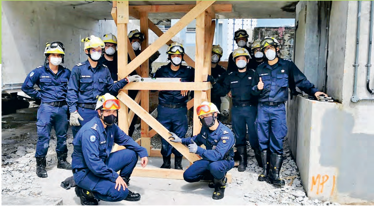
Wang Mingkang与队友搭建的三级垂直支撑架，可在灾场中暂时稳住受损的混凝土结构。
